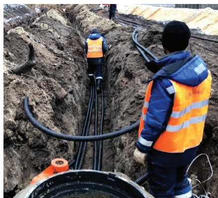
Технология строительства городской кабельной канализации
